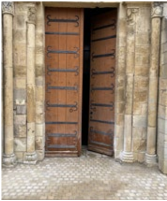
RÉFECTION DU PARVIS DE L'ÉGLISE
