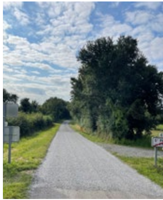
TRAVAUX ROUTIERS ROUTE D'AZY-LE-VIF
